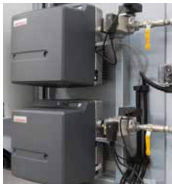
Quemador de gas para el calentamiento del horno y el sistema de postcombustión térmica
