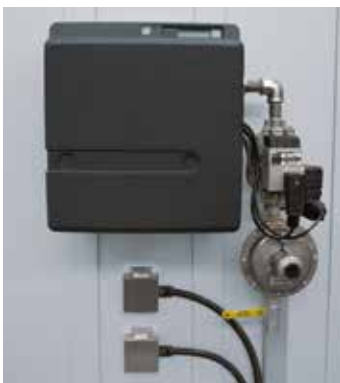
Quemador compacto para modelos estándar hasta NB 600
