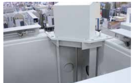
Carga de gas de protección sobre el borde contra incendios
