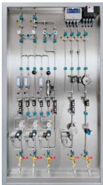
Sistema de control del gas
